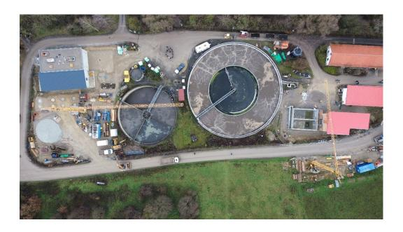
Bereits Mitte November ist das erneuerte Zulaufhebewerk mit drei neuen, energieeffizienten Pumpen in Betrieb gegangen. Im südlichen Teil der Kläranlage wurden zudem das Vorklärbecken und der Rohbau des neuen Maschinenhauses für den Sandfang und das Primärschlammpumpwerk errichtet.
