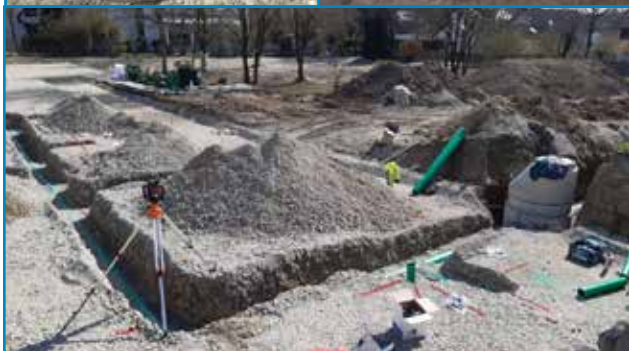
Erdbauarbeiten für das Haus für Kinder
