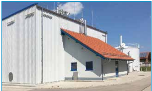
Beispielfoto: Faulturm der Stadt Marktoberdorf (Quelle: Ing. Büro GFM)
