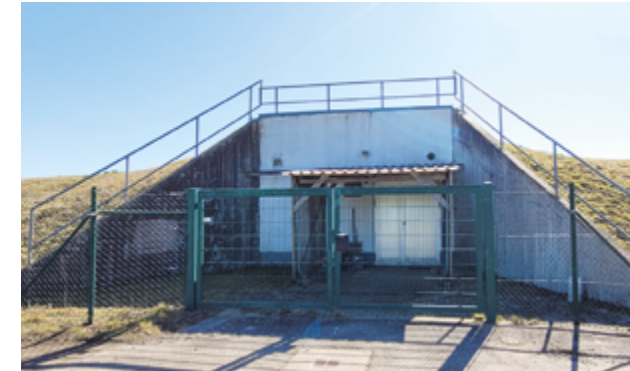
Der Hochbehälter in Petzenhofen wird von den zwei Brunnen in Walleshausen gespeist.
