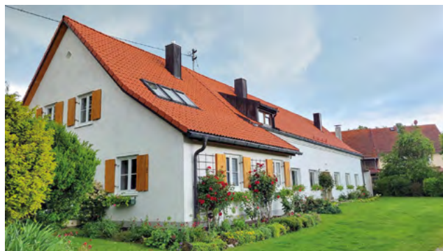
▲ 1952/53 wurde ein Anbau als Wohnung vor die Weberei angegliedert.
