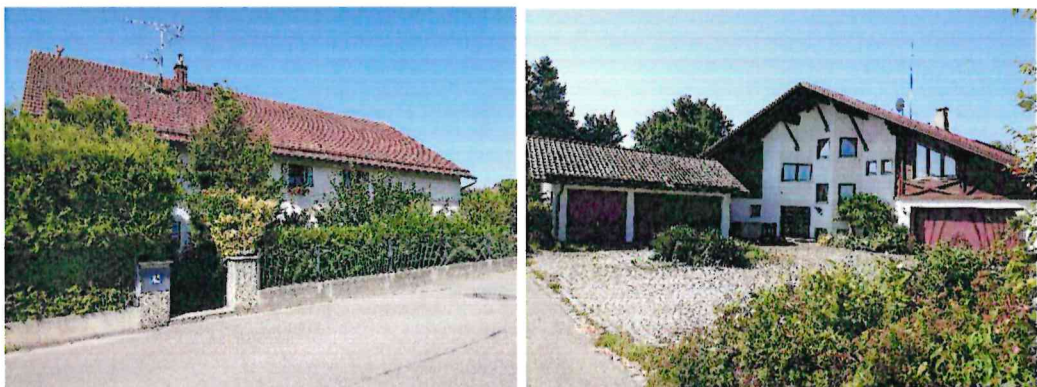
Abb. 4, 5 Gebäude Hauptstraße 23 und 21, Quelle: PV
