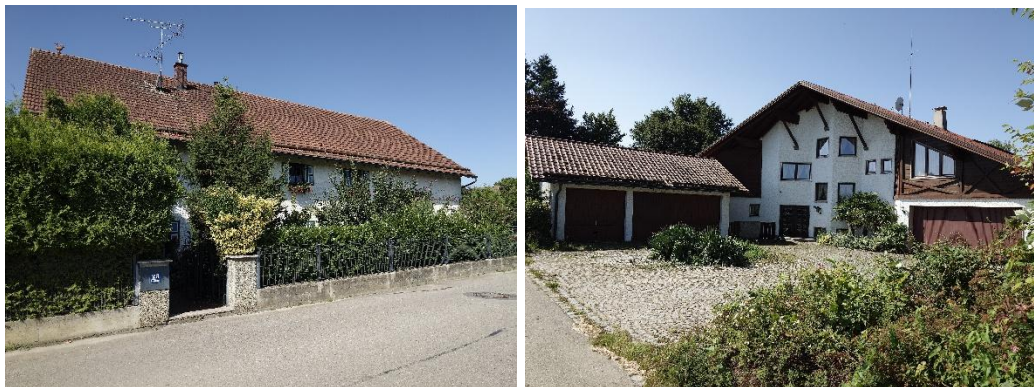
Abb. 4, 5 Gebäude Hauptstraße 23 und 21, Quelle: PV
