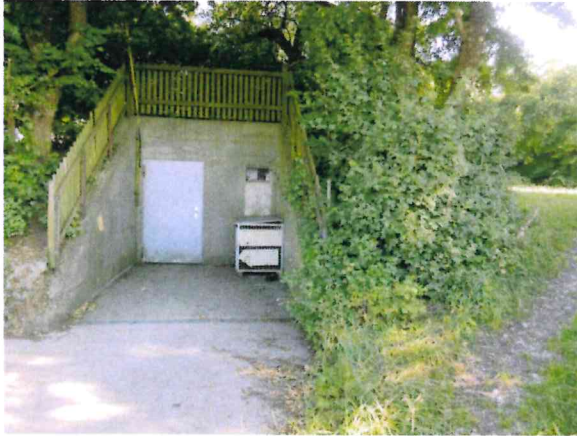
Foto 1: Blick auf den abzubrechenden Wasserhochbehälter am Nordostrand, hier entsteht die künftige Alarmausfahrt.
