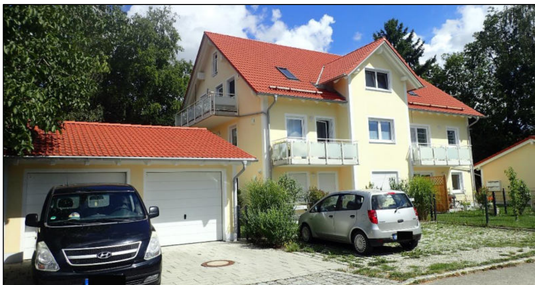
Abb. 5 zweigeschossiges Mehrfamilienhaus mit 6 Wohneinheiten im Heuweg 18; mit Zwerchgiebel; Quelle: PV; Aufgenommen am 19.08.2020
