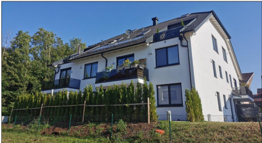
Abb. 22 2019 durch die 11. Änderung des Bebauungsplanes „Geltendorf Süd, südlicher Teil “ ermöglichtes Mehrfamilienhaus westlich der Bahnhofstraße mit städtebaulich verträglich umgesetzten Dacheinschnitten; Quelle: PV; Aufgenommen am 30.07.2020
