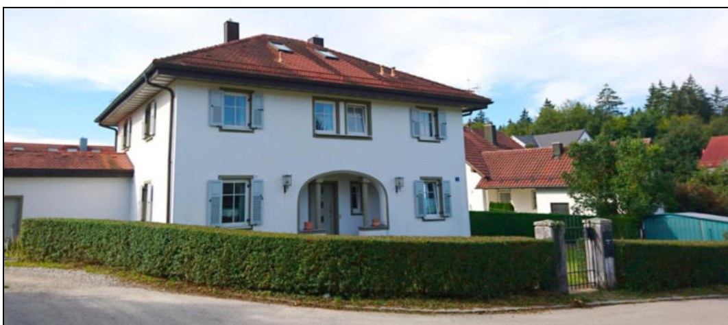
Abb. 6 Einfamilienhaus mit Walmdach im Fichtenweg 5; Quelle: PV; Aufgenommen am 10.09.2020
