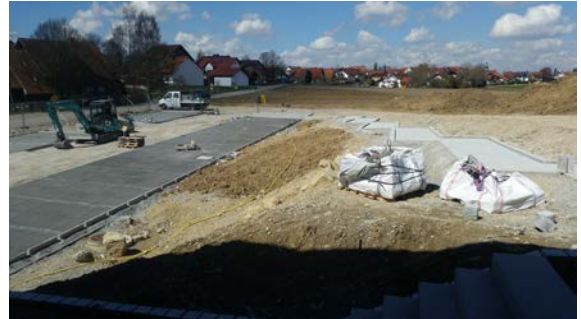
Blick vom Flur auf den späteren behindertengerechten Aufgang und die Parkplätze
