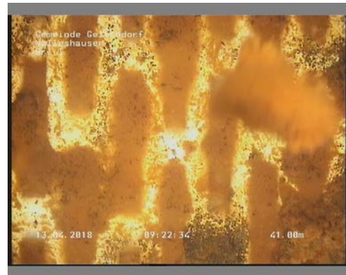
Hier sieht man nochmals Nahaufnahmen von den Verstopften Filterschlitzten auf einer Tiefe von 41 Meter
