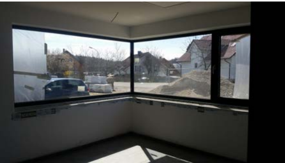
Die Funkzentrale bereits gefliest, gestrichen und mit den Anschlüssen
