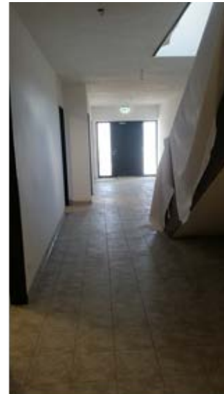
Flur von der Herrenumkleide Richtung Haupteingang
