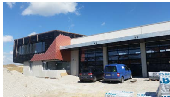
Vordach aus der Nähe, die Verblendung des Vordaches kommt noch
