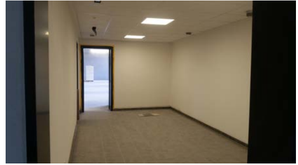
Die spätere Damenumkleide mit Blick in die Halle
