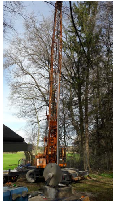
Heben bzw. Ausbau des Gestänges im Brunnen I am 12.04.2018
