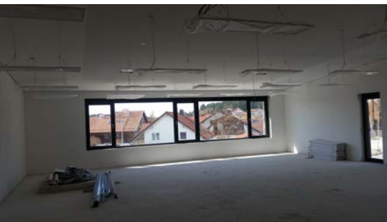
Schulungsraum im OG mit bereits befestigten Lampen
