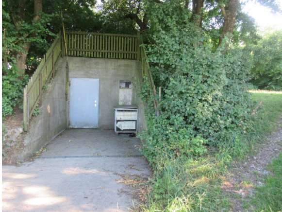
Foto 1: Blick auf den abzubauenden Wasserhochbehälter am Nordostrand, hier entsteht die künftige Alarmausfahrt.
