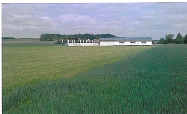
Abb. 3: Halle nördlich des Planungsgebietes
