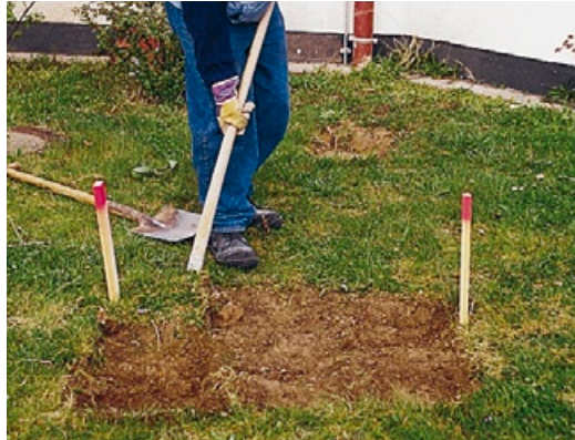
Abb. links: Abstecken der Baugrube.
