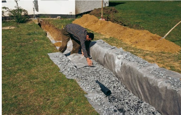
Abb. links: Anschluss des Versickerungsrohrs.
