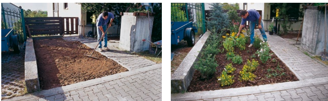
Abb. links: Aufbringen des Mutter- bodens.
