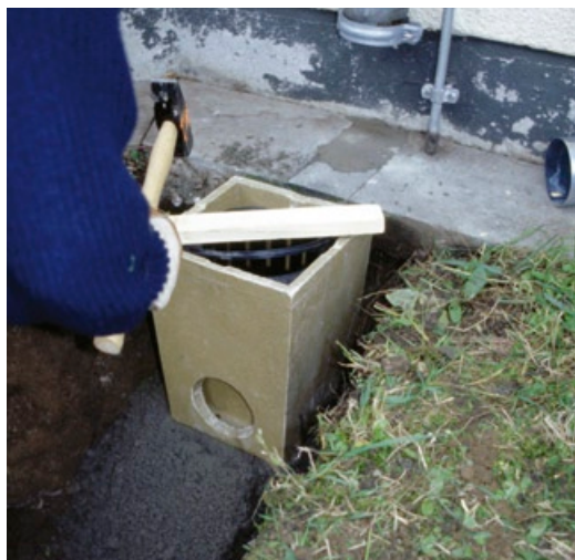
Abb. rechts: Rigolenbereich ausheben.
