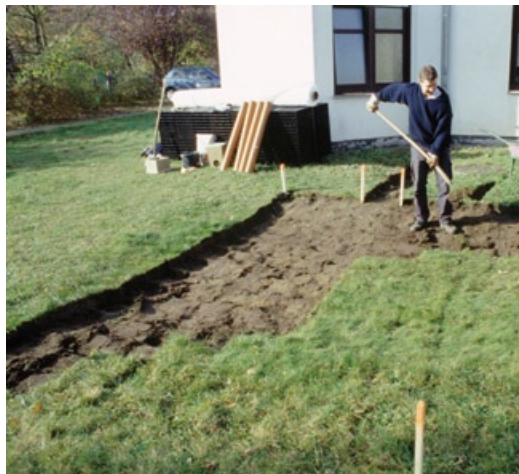
Abb. links: Abstecken der Baugrube.
