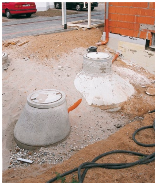
Abb.: Regenwasserspeicher kombiniert mit Versickerung.
