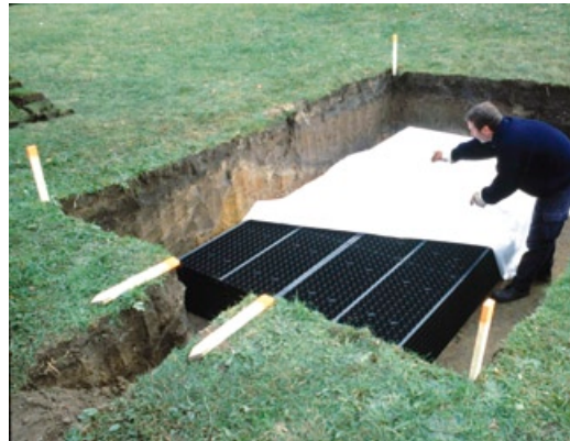
Abb. links: Einsetzen der Kunststoffelemente.
