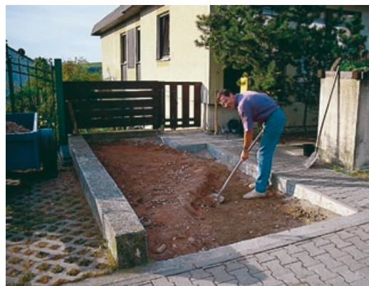
Abb. links: Randsteine setzen.
