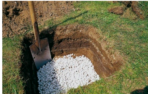
Abb. links oben: Ausheben der Grube.
