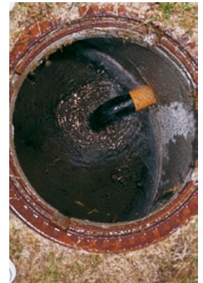
Abb.: Schacht aus Beton
