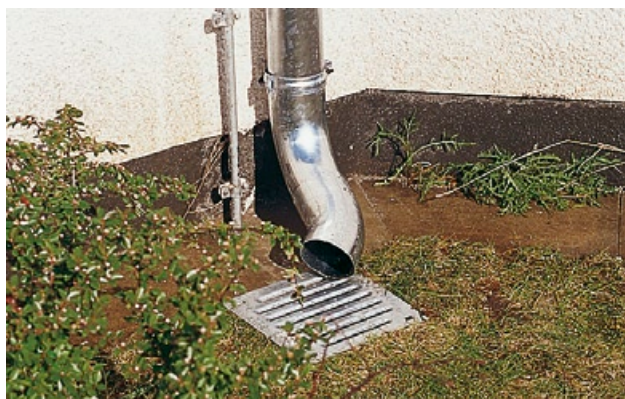
Abb. links: Mutterboden auffüllen und Rasenschollen ergänzen.
