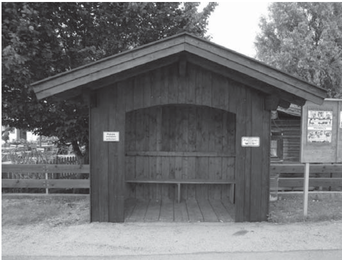
Endzustand nach Renovierung
