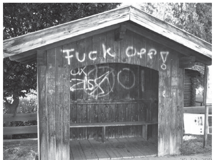
Ausgangszustand vor Renovierung
